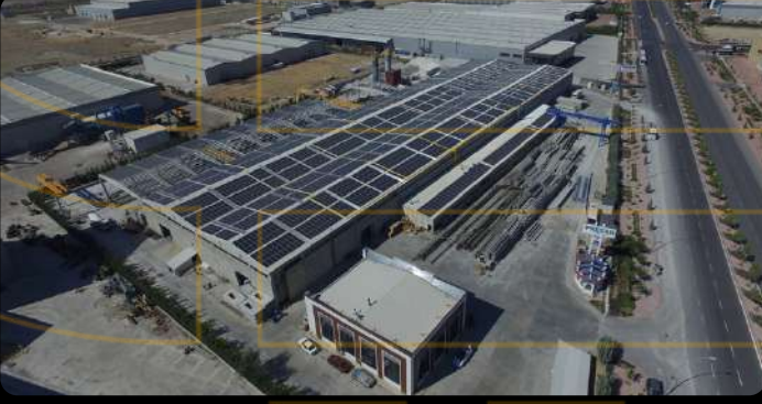
KONYA - PRESAN GES - 1250KWP
