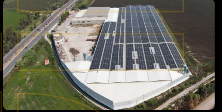
AYDIN - GERMENCİK GES - 1500KWP
